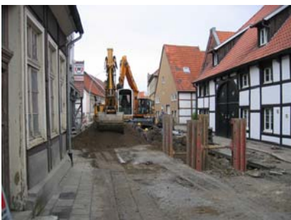
9077 Kanalerneuerung Stadt WAF
