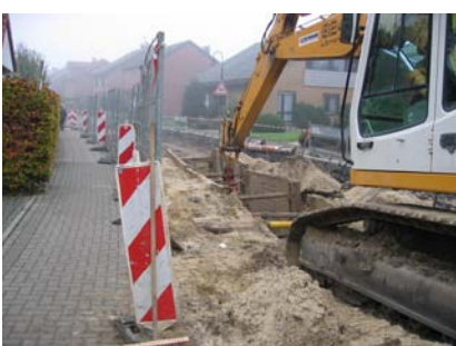
9086 Kanalerneuerung Stadt WAF
