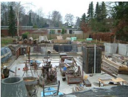
9067 Neubau Mehrfamilienwohnhaus in MS
