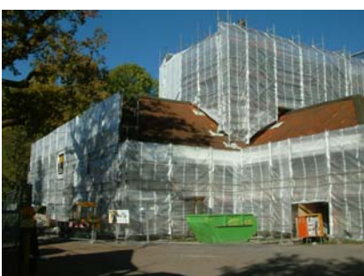
9073 Restaurierung Luisenhütte Balve
