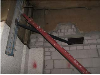
9055 Sanierung Bf. Rheda-Wiedenbrück
