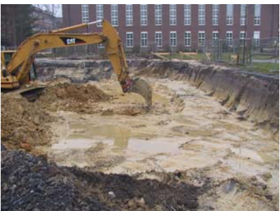
9051 Neubau Parkhaus und Entsorgungshof
