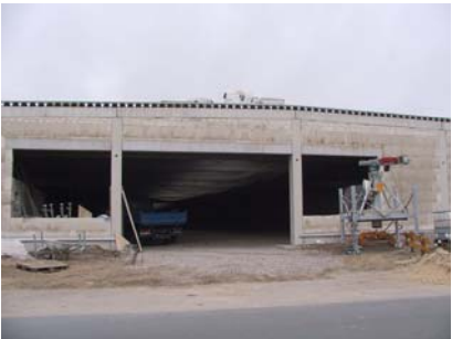
9048 Neubau Produktions- und Lagerhalle
