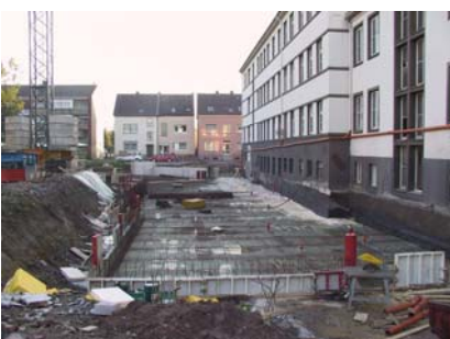
9052 Evangelisches Krankenhaus Hamm
