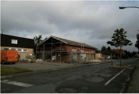
9045 Renovierung Volksbank Gronau - Epe
