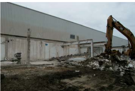
9042 Anbau Technikgebäude - Fa. Amoco
