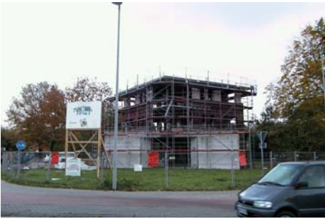
9035 Neubau Volksbank Ahaus
