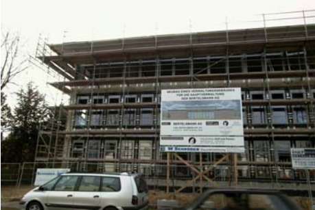
9036 Neubau Bertelsmann Gütersloh
