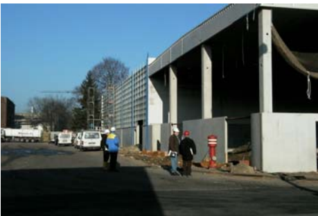
9037 Neubau Magazin - Phenolchemie
