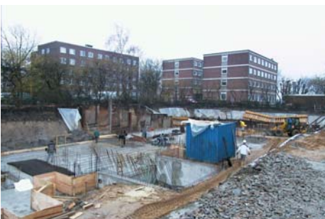
9024 Neubau Horstmarer Landweg
