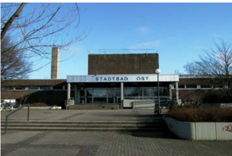
9023 Sanierung Stadtbad Münster Ost
