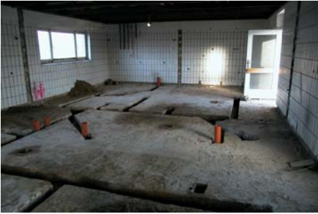
9020 Sanierung Erlbad in Drensteinfurt
