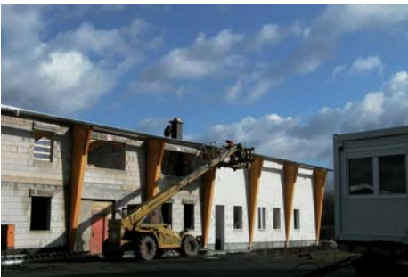
9022 Betriebshalle Fa. Planttech
