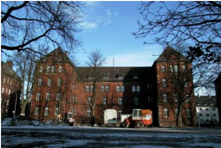
9015 Umbau Fachschaft Architektur in Münster
