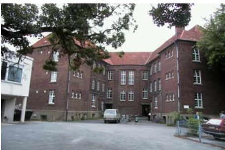
9018 Dachsanierung Geb. Schulstraße
