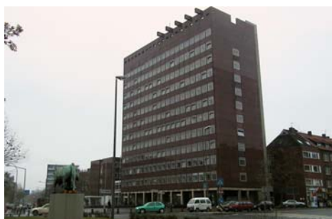
9011 Sanierung Stadthaus II
