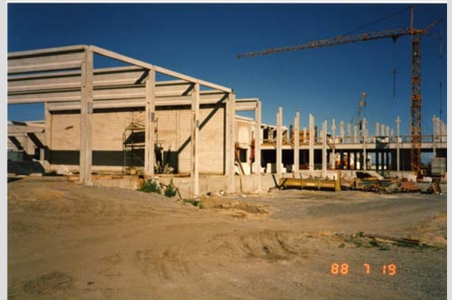
Rohbau Fertigteilhalle
