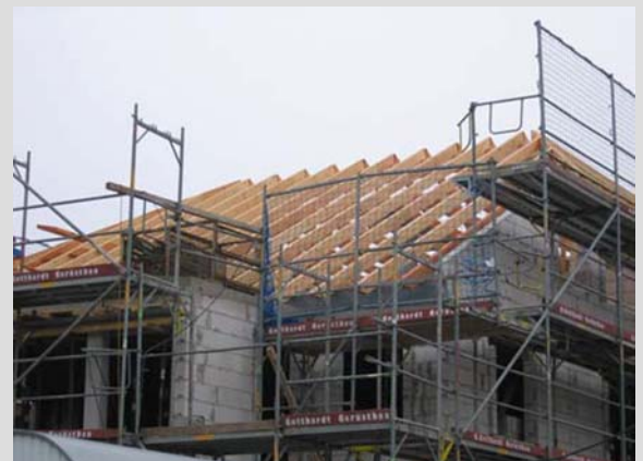
Errichten des Dachstuhles
