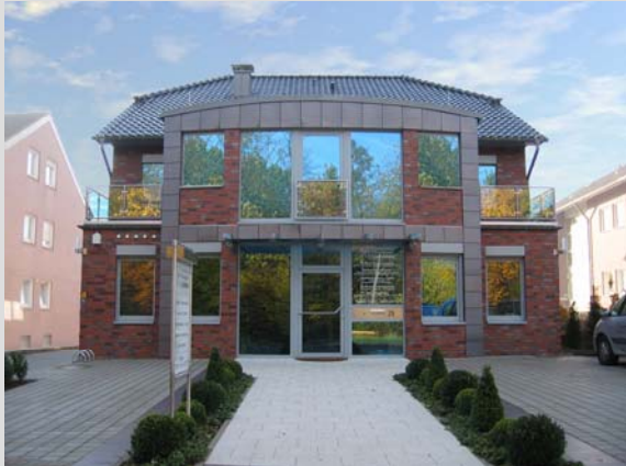
Vorderansicht Wohn- und Bürogebäude
