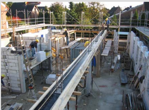
Erstellen des Kellergeschosses
