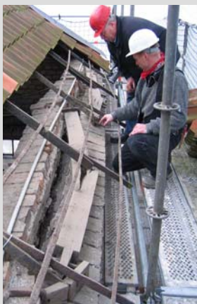
Reparaturarbeiten an Stahldachkonstruktion
