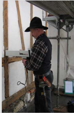
Bearbeitung der Fachwerkkonstruktion
