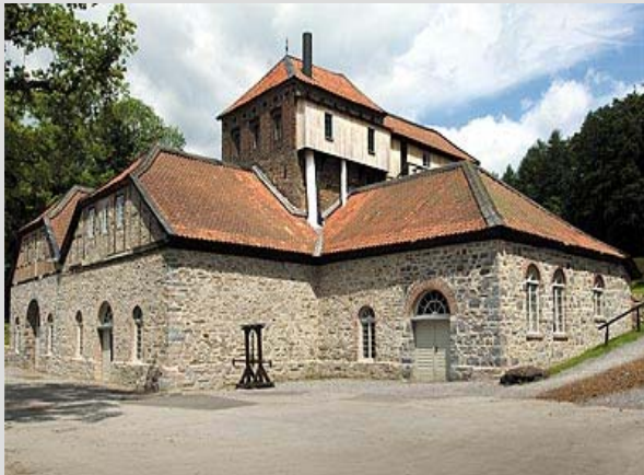
Luisenhütte nach den Restaurierungsarbeiten
