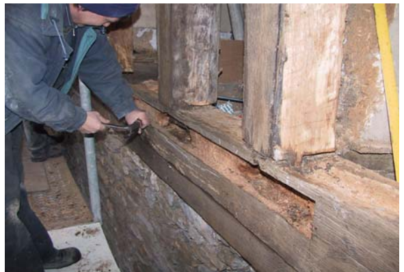
Fachwerkrestaurierung an der Gießhalle
