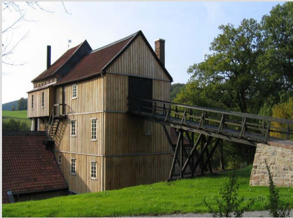
Neue Holzverschalung Möllerboden
