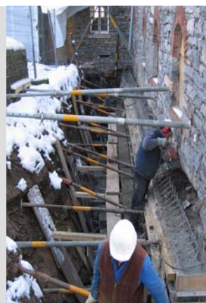
Neue Stützwand mit Drainage
