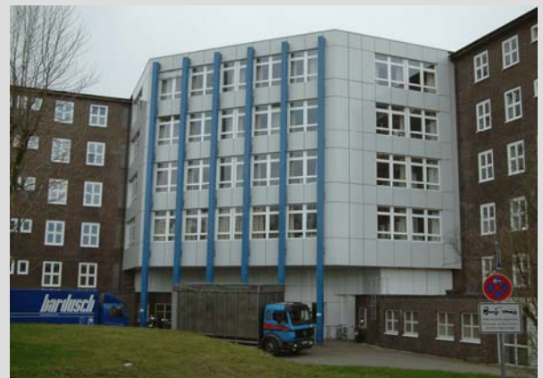
Marienhospital Bottrop Verbindungsbauteil
