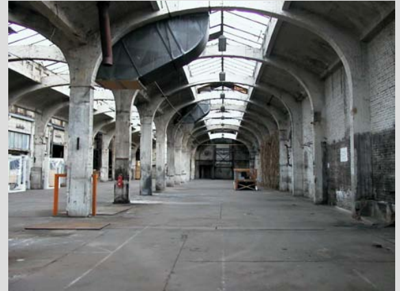
Alte Tragkonstruktion aus Korbbögen
