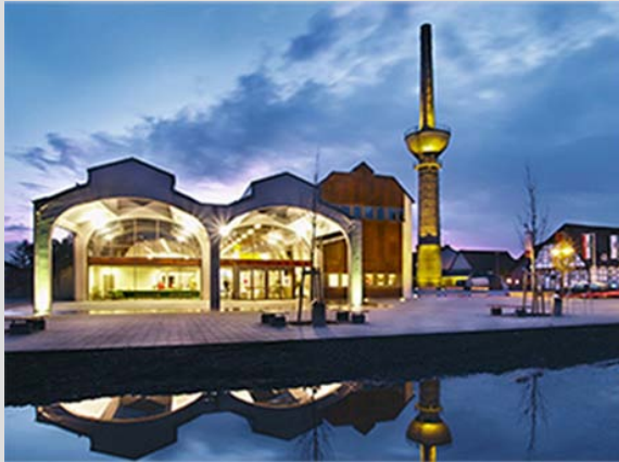
Sanierte Gempt - Halle in Lengerich
