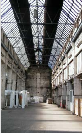
Hallenausbildung mit Fachwerkkonstruktion
