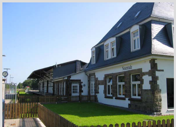
Rückseite des sanierten Gebäude
